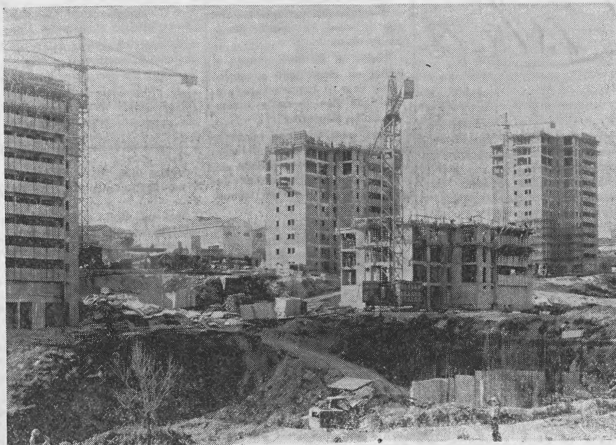
Construção de moradias destinadas a Famílias que hão-de mudar-se de acordo com o «Plano de Renovação do Barredo».
